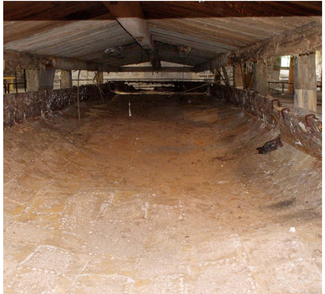
Magazzini del sale prima del restauro
