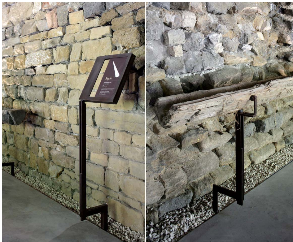
Muri in pietra: edificio preesistente
